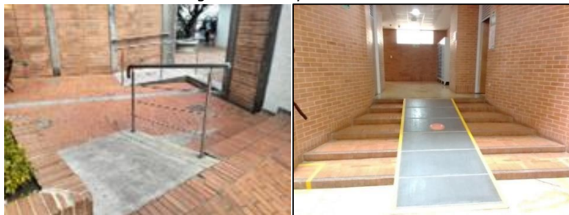
Figura 68. Rampas de acceso
